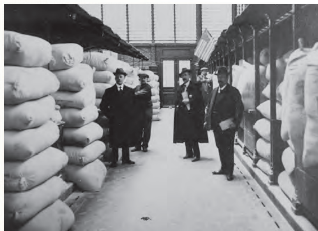
Des sacs de farine sont entassés dans les anciennes halles.
