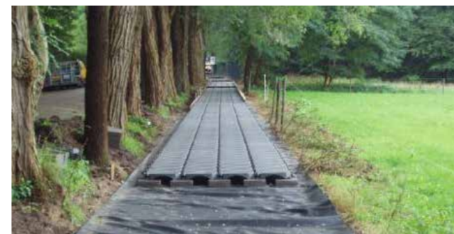
Le sentier et sa fondation en cassette coupole
